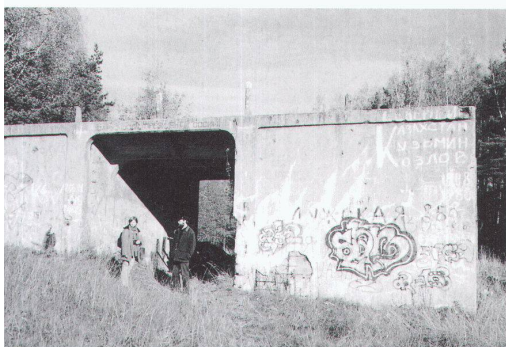
Maillart + Co., Brücke mit Kastenkonstruktion der nicht vollendeten Tramway-Linie Oranella, Strelina-Oranienbaum, 1915
