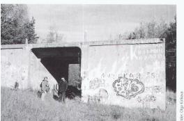
Maillart + Co., Brücke mit Kastenkonstruktion der nicht vollendeten Tramway-Linie Oranela, Strelna-Oranienbaum, 1915
