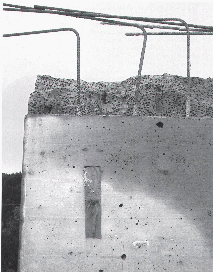
Konstruktionsdämmbeton mit Zuschlägen aus Blähton und Blähglas. – Bild: Felix Jerusalem, ETH Zürich.
