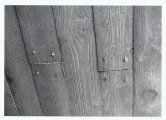
SVB hinterlässt ein gestochen scharfes Abbild der Schalungsstruktur, wie hier beim Science Center «Phaeno». – Bild aus: Beton- und Stahlbetonbau, Heft 1, 2004.
