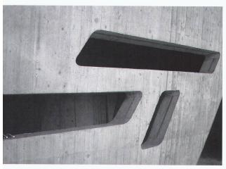
Selbstverdichtender Beton (SVB) für Zaha Hadids Science Center «Phaeno» in Wolfsburg (2002–2005). Selbst bei «unmögliche» Anordnung werden die Öffnungen vollständig umschlossen. – Bild aus: Beton- und Stahlbetonbau, Heft 1, 2004.
