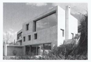
Erreicht mit 45 cm dicken Aussenwänden einen U-Wert von 0.54 W/m³K: Eigenheim des Ingenieurs und Architekten Patrick Gartmann in Chur (2002–2003). Bild: Reto Gadola, ETH Zürich.
