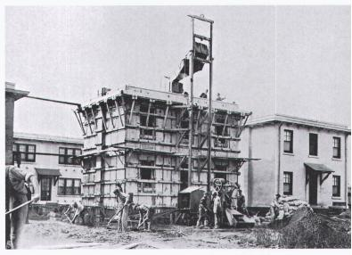
Gussbeton als Vorläufer von selbstverdichtendem Beton. 1909 baute Thomas Alva Edison (1847–1931) in Philipsburg (USA) zweigeschossige Häuser, die in einem Guss betoniert wurden – Decken, Trennwände und Badewanne eingeschlossen. – Bild aus: Peter Collins. Concrete, London 1959.
