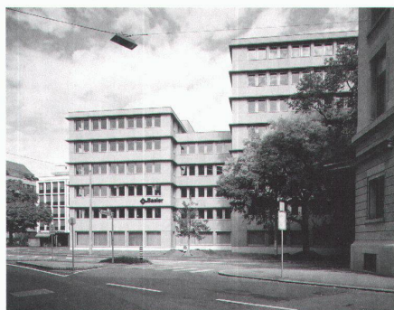
Diener & Diener, Verwaltungsgebäude Picassoplatz, Basel 1993 Bild: A. Zanetta
