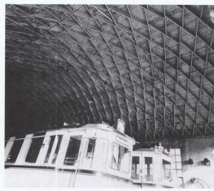
Strassenbahndepot Stuttgart-Ostfildern, 1926–1928, Zollbau-Lamellendach. Bild: Berthold Burkhardt, aus: R. Graefe, wie Anm. 10
