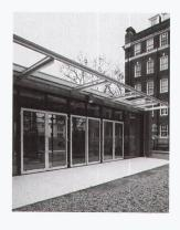
des Fenstersystems CS 38-Slim Line von Reynaers Aluminium war die Konstruktion eines offenen und transparenten Gebäudes möglich, das dem historischen Erbe des bestehenden Bauwerks Rechnung trägt. Die Glasfassade des Pavillons als neuer Eingangsbereich bietet nicht nur Aussicht auf die Gärten des Gebäudes, sondern auch auf die berühmte Royal Albert Hall.
