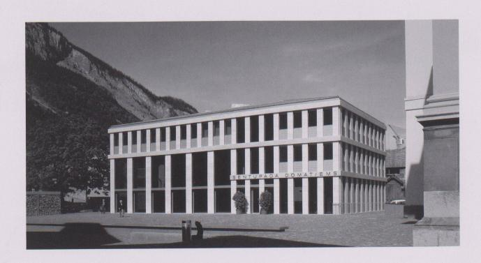
zwischen den einzelnen Wandscheiben dienen als Installationszonen, die Raumtrennwände sind in Leichtbau ausgebildet und können bei Bedarf versetzt werden.
