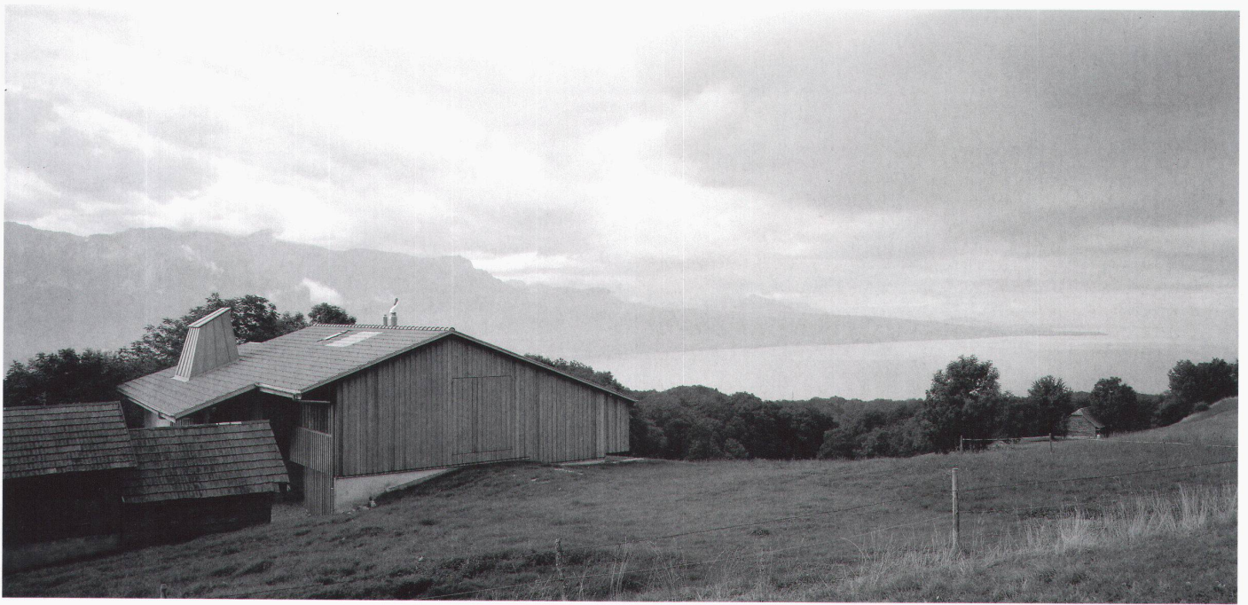
Planung und Bau: 2001–2004 Projektarchitekt: Vincent Jeauffre Ingenieur: MCR et associés, Vevey Zimmermann: AXE Charpente, Roche Bilder: Marco Bakker
