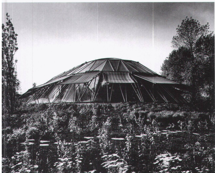
«Schildkröte» (1953), Gewächshäuser und Brücke (1963) in «Planten un Blomen». – Bilder: E. Troeger (links), U. Becker-Mosbach (rechts)
