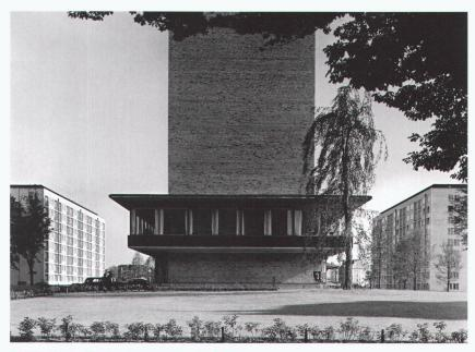
Grindelhochhäuser, Stirnseite mit Kraggeschoss. – Bild: E. Scheel
