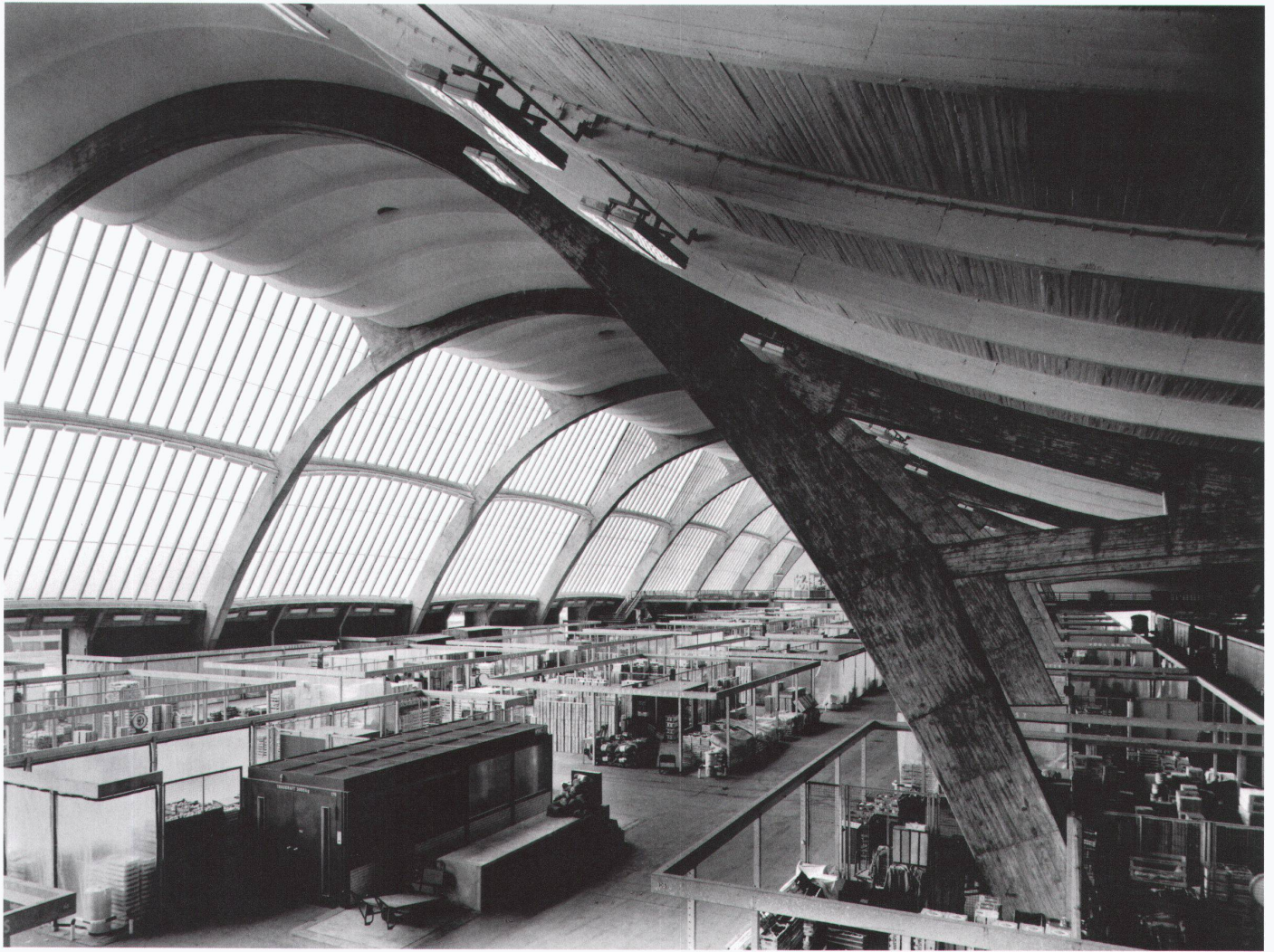
Grossmarkthallen, Innenansicht. – Bild: E. Becker-Mosbach
