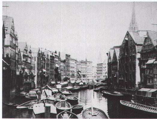
Das Nikolaifleet mit Speichergiebeln, historische Aufnahme um 1880
