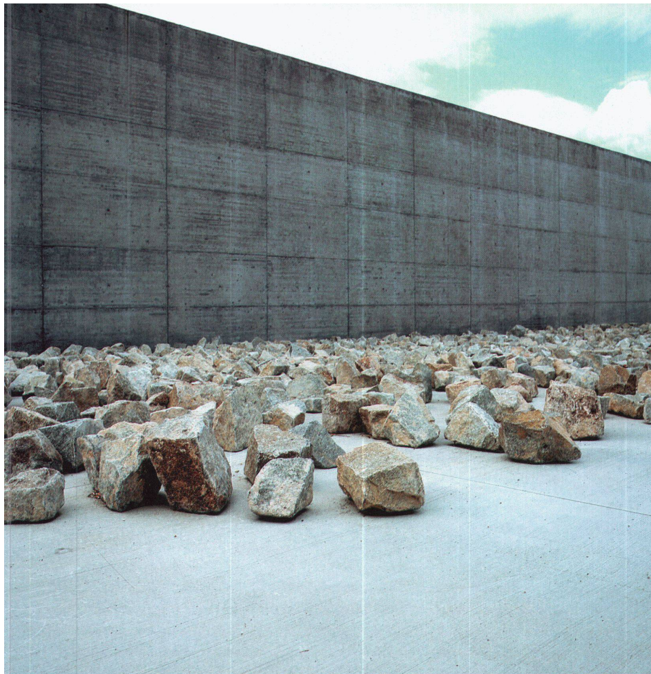
Stützmauer; davor ausgelegte Steine der ehemaligen Mauer. – Bild: Elisabeth Wörndl
