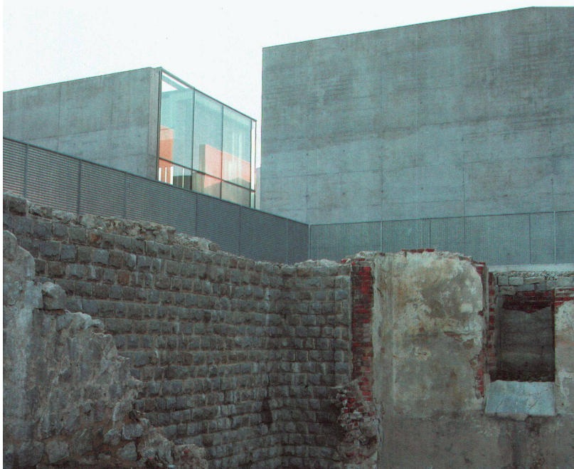
Südlicher Eingang, davor Reste eines Kellers aus der NS-Zeit. – Bild: Herwig Mayer
