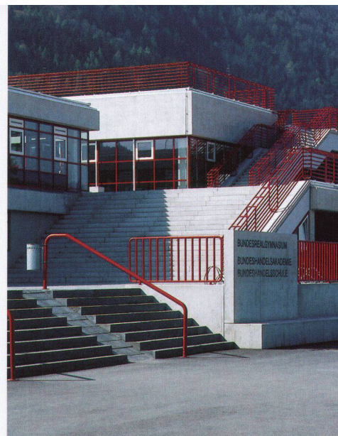
Zugang und Aufgang auf die Terrassen
