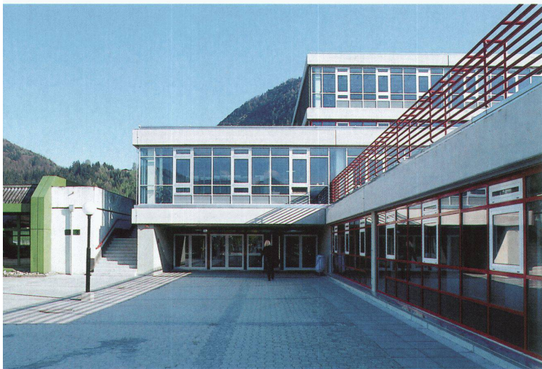
Zugang. Über dem Eingang die erweiterte Verwaltung, rechts die Zentralgarderobe
