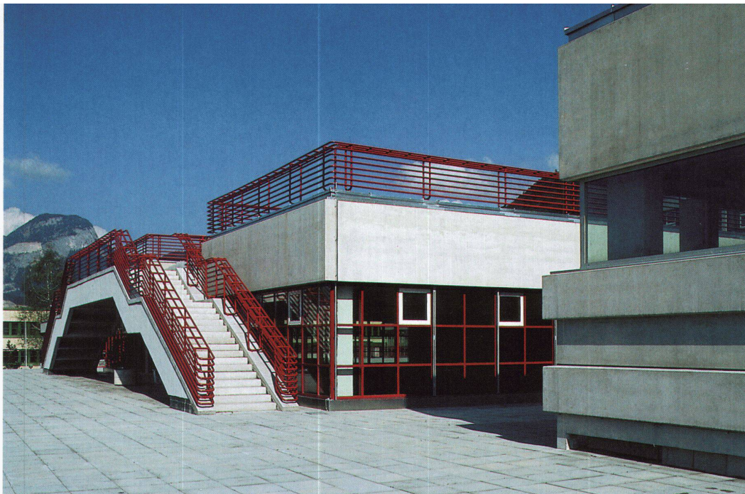
Terrasse, rechts die neue, im Zentrum die alte Turnhalle
