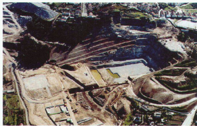
Das Stadion im Bau. – Bild oben: Luis Ferreira Alves
