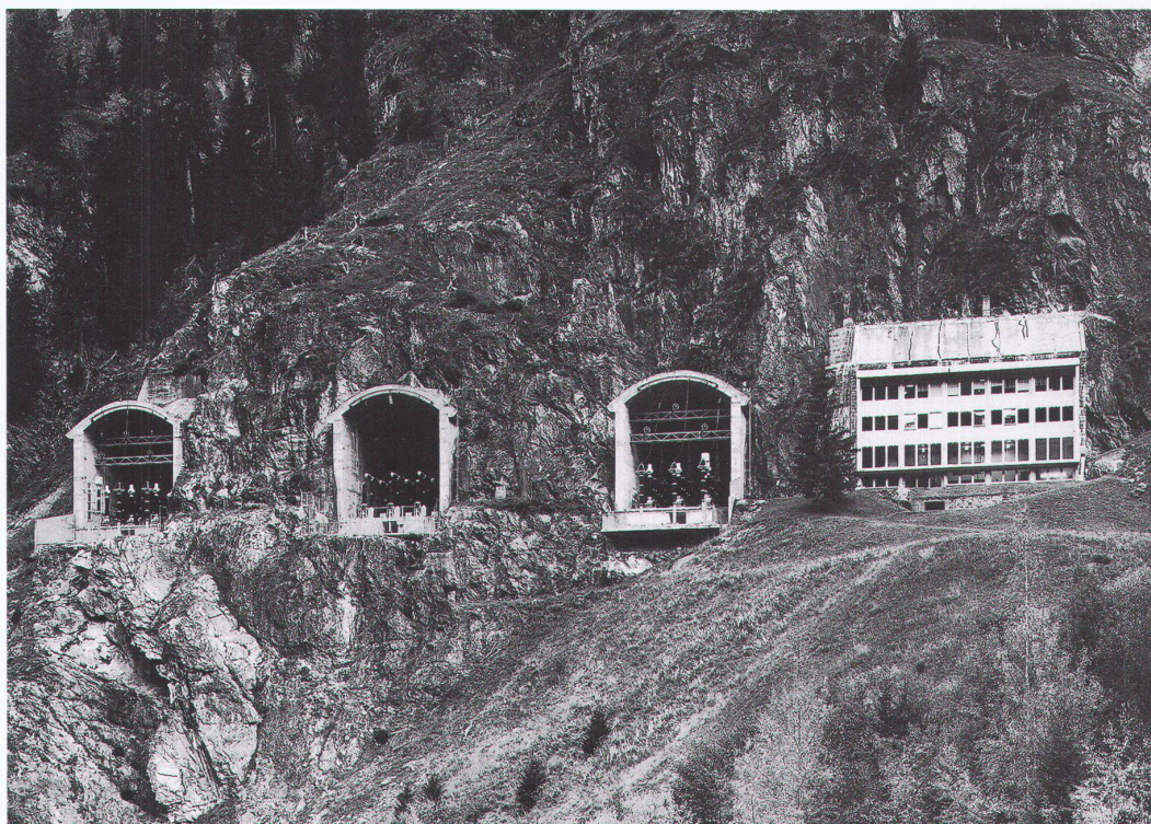
Zentrale Fionnay, Leitungsabgänge und Betriebsgebäude. – Bild aus: Alessandro Botteri Balli, Wasserkraftwerke der Schweiz, Architektur und Technik, Zürich 2003
