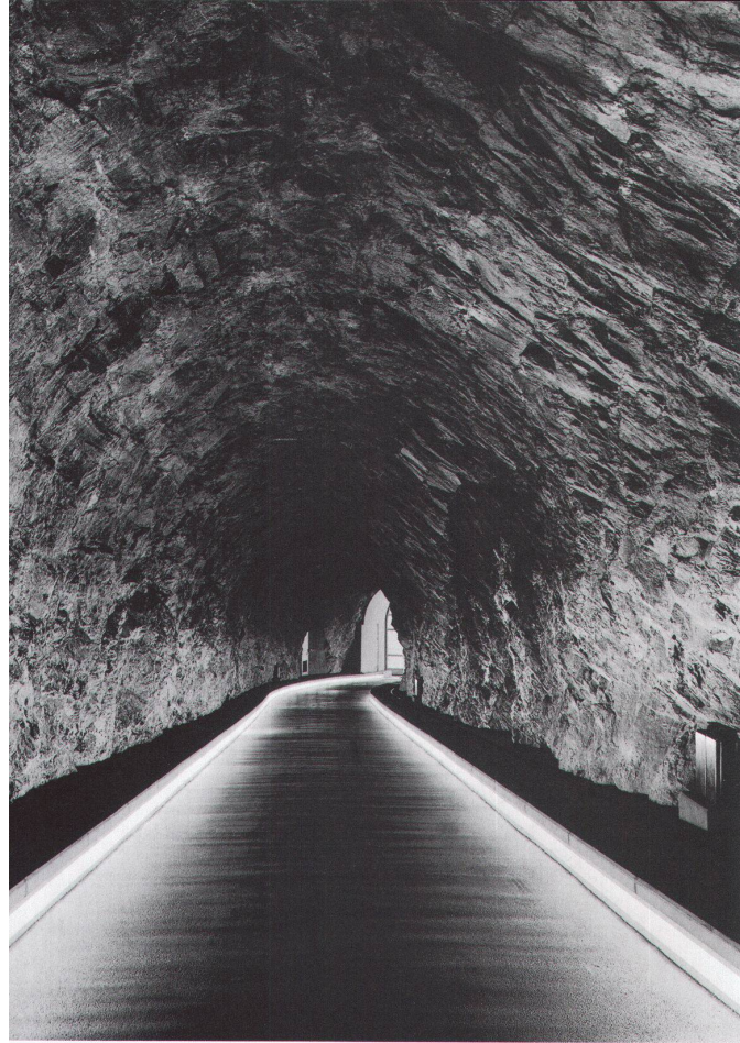
Zugangsstollen Zentrale Ferrera. – Bild: Christian Kerez
