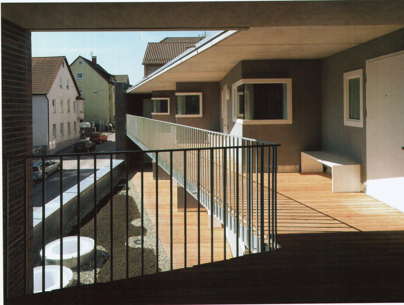
Laubengang mit Küchenfenstern und Eingangsnischen
