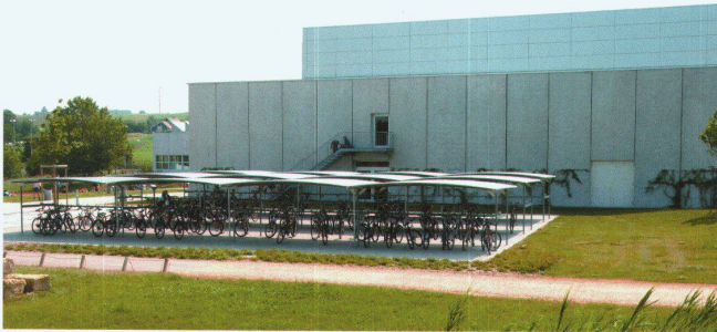
Überdachungen doppelseitig, offen, in Querrichtung vervielfacht.
