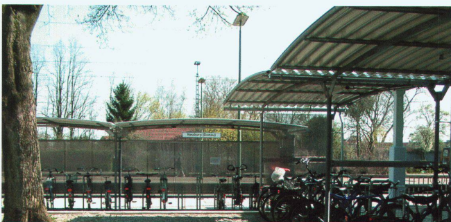
Überdachung einseitig, Wände aus Lochblech (nichtrostender Chrom-/Edelstahl).
