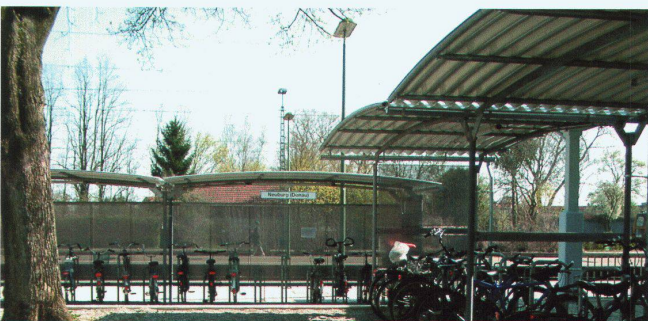
Überdachung einseitig, Wände aus Lochblech (nichtrostender Chrom-/Edelstahl).
