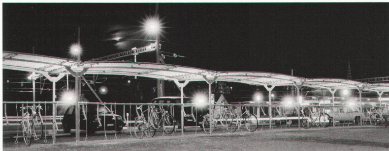
Einseitige Ausführung, Dach als Lichtreflektor.
