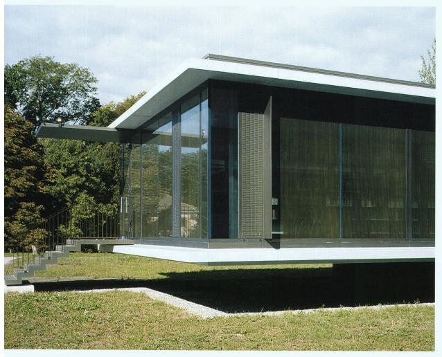
innen und aussen hervor. Die unscheinbare Konstruktion klebt buchstäblich an der Raumhülle, dass sich die unterschiedlichen Bezüge zwischen innen und aussen frei entwickeln können (tragende Wände zwischen den Klassenzimmern, vorgefertigte Teile für die rückwärtige Mauer, Metallstützen entlang der Fensterfront).
