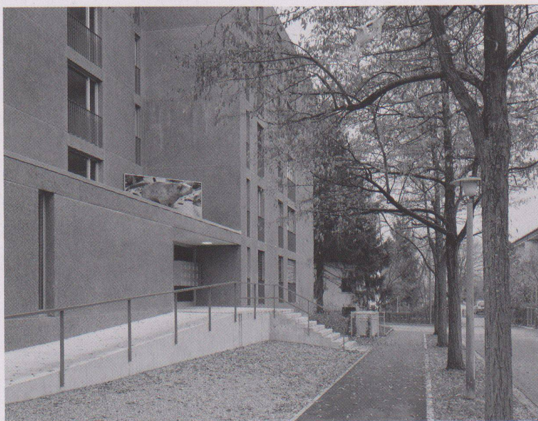
Bilder: Georg Aerni, von Ballmoos Krucker (Baustellenfotos)
