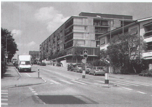
Siedlung Eichrain von der Glattalstrasse aus
