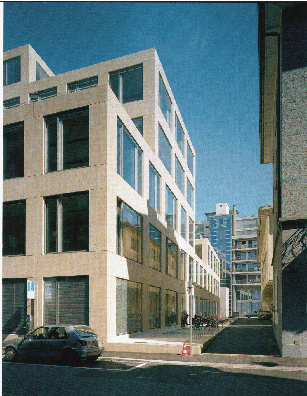
Rückwärtige Fassade mit Blick nach Osten
