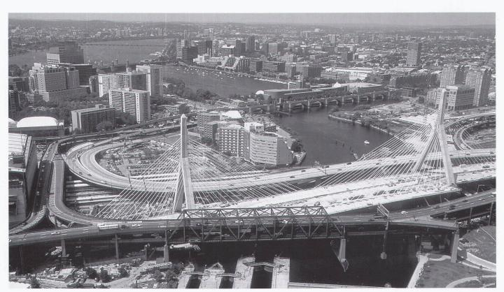
2002: bis zur Fertigstellung der Zakim Bridge bleibt die doppelstöckige Autobahnbrücke von 1959 in Betrieb. Dies verunmöglichte eine durchgängig seitliche Anordung der Kabel. Oberhalb der Zakim Bridge der Leverett-Zubringer, im Hintergrund das Charles River Becken mit den Esplanaden von Boston und Cambridge.
