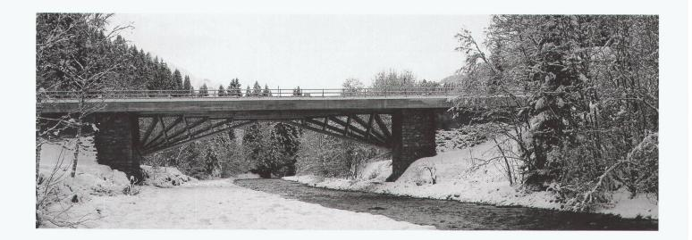
Man darf annehmen, dass sich dieser Eindruck mit der Zeit etwas abschwächen wird, wenn sich Beton und Holz durch Patina und Vergrauen farblich annähern werden. Diese Angleichung wird durch die Wahl einer horizontalen Bretterschalung für den Kordon unterstützt.
