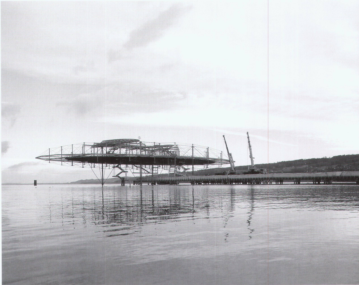
Arteplage Yverdon-les-Bains, Struktur der Wolke, im Bau
