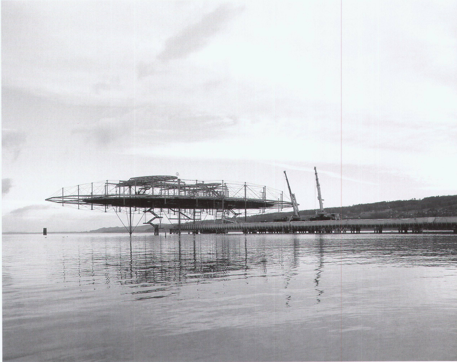
Arteplage Yverdon-les-Bains, Struktur der Wolke, im Bau
