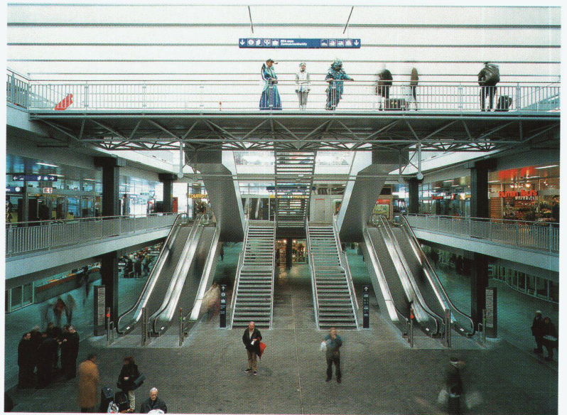
Frank Geiser, Renovation der zentralen Halle mit neuen Treppen und Passerelle, 1998/1999. Die Erneuerung diente einerseits der besseren Erschliessung der Geschosse und andererseits einer Auffrischung der ästhetischen Erscheinung. Die Halle wirkt heller und eleganter. (Foto: Sacha Geiser)
