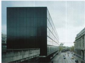
Rolf Mühlethaler, Sanierung und Attikaaufstockung Dienstgebäude Bollwerk Nord, 1997–2001. Das bestehende Gebäude mit Tragstruktur aus Beton und Stahl erhielt eine neue doppelhäutige Fassade in Leichtmetall und Stahl. Das Innere wurde durch mobile Trennwände in Metall bzw. eine Grossraumstruktur mit raumtrennenden Schränken neu gegliedert. Siehe auch wbw 03/2001. (Fotos: Daphné Iseli)
