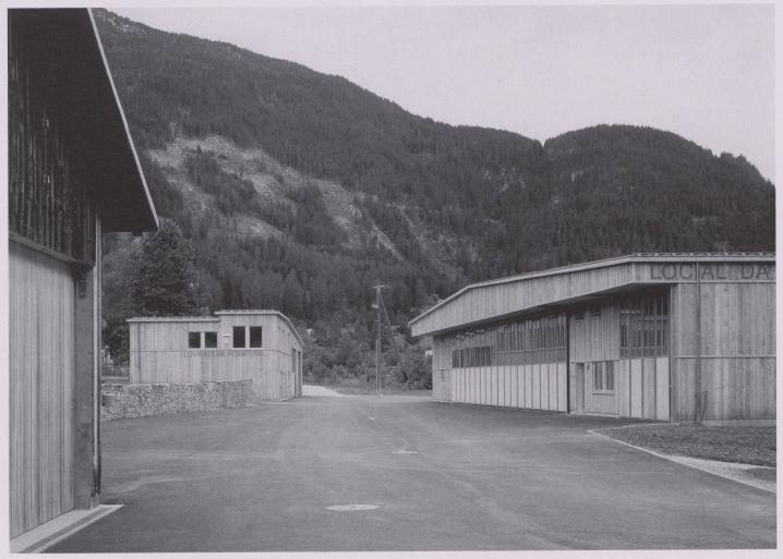
stehende Schalung aus Lärchenholz. Die nordseitig aus beiden Gebäuden herausragenden, raumhohen Dachgauben werden zum Ausdruck einer minimalen städtebaulichen Geste und verweisen auf die Zusammenhänge zwischen Ort und Funktion.
