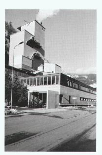
Die Erschliessungstreppe musste auf die bestehende Rippendecke Rücksicht nehmen; das Tragwerk der Aufstockung überbrückt stützenlos 15 m. Zwei
