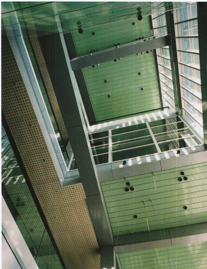
Vierendeel truss construction ▷ Bau der Vierendeel-Träger ▷ Construction des poutres Vierendeel
