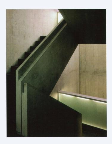
Vorgefertigte Treppe im massiven Kern
