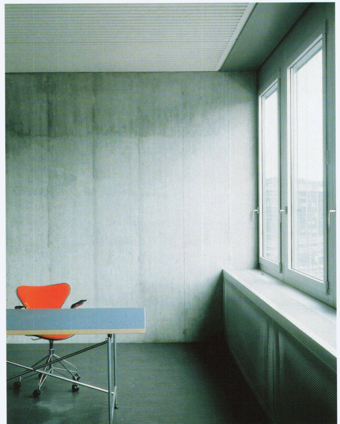
Büro mit Weisszement- Deckenelementen
