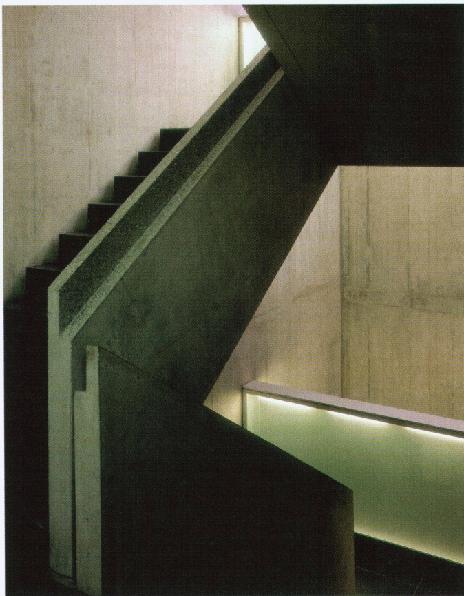
Vorgefertigte Treppe im massiven Kern
