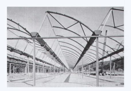
Konstruktion einer mehrschiffigen Shedhalle (Müller AG, Brugg)
