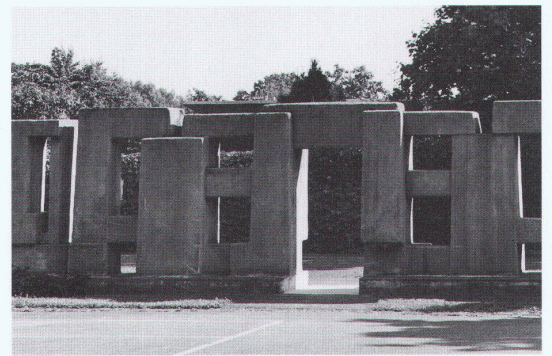
Zwischen Parkplatz und Haupteingang durchbrochene Mauer von Robert Lienhard
