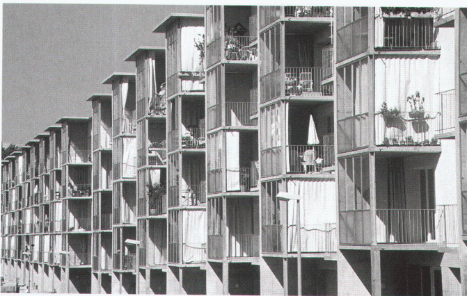
Wohnüberbauung Luzernerring, Basel, Ausschnitt der Südwestfassade
