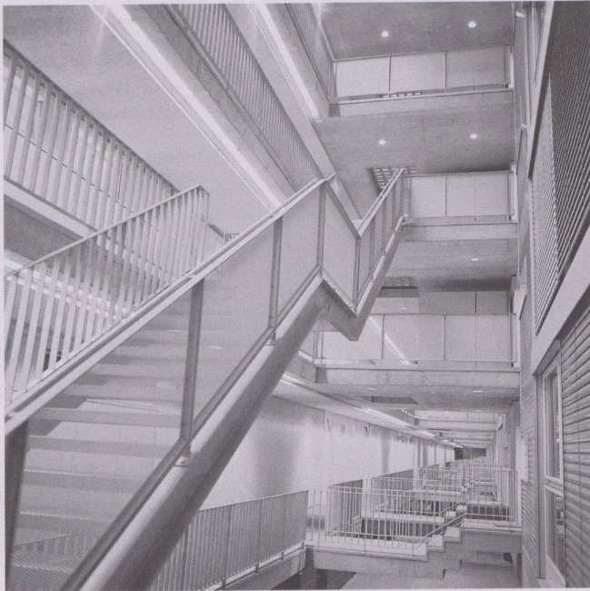
14 15 «Passage» im Trakt 2 mit Kaskadentreppe und «Wohnungsbrücken»
