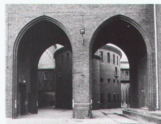
Das Abspannwerk «Humboldt» an der Kopenhagener Strasse, Sitz des Berliner Vitra Design Museums
