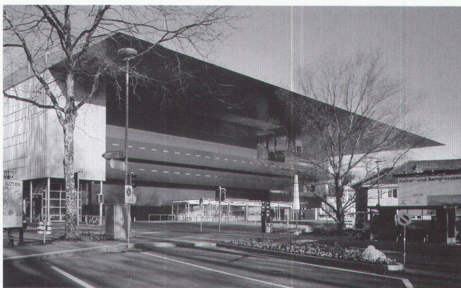
Fassade Konzertsaal und Serviceschicht ▷ Façade de la salle philharmonique et couche auxiliaire
