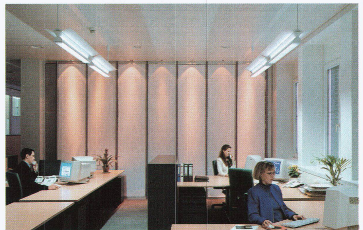
Am Abend: Ausschliesslich direkte Beleuchtung mit grosser Wandaufhellung
