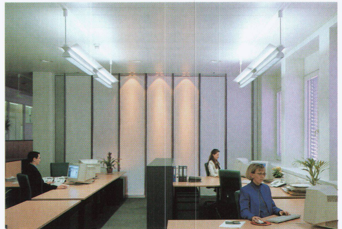
Am Mittag: Der Direktanteil wird verstärkt und die Wand leicht aufgehellt
