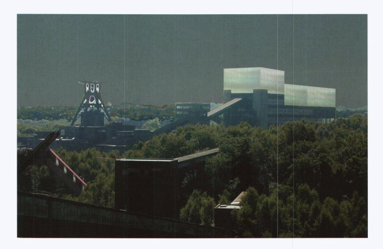
Lösung der Gebäudesanierung. Indem die Kohlenwäsche auch künftig nur minimal temperiert werden muss, kann auf eine neue Fassadenisolation, welche einen beträchtlichen Eingriff in die bauliche Substanz mit sich bringen würde, verzichtet werden.
