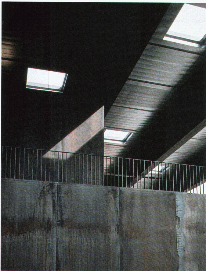
Halle 9 de l'OLMA, Saint-Gall, 1999 Architectes: Bétrix & Consolascio avec Eric Maier, Erlenbach Responsable du projet: Marc Aurel Wyss Collaboration: Gerardo Casciano, Oliver Strub Ingénieurs civils: Dr. Lüchinger + Meyer AG, Zurich; Schällibaum AG, Wattwil Entreprise générale: Allreal AG, Zurich Responsable du projet: Alex Brotzer
