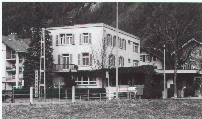
Zustand vor der Aufstockung (Umbau 1965, Ernst E. Andereg, Meiringen)
