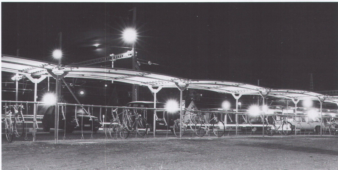
Fahrradüberdachung einseitig, Bahnhof Turgi, Dach als Lichtreflektor
