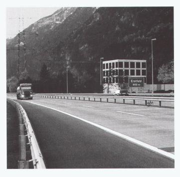
Die Materialisierung aus Ortbeton, Glas und Aluminium verleiht dem Bau eine Rauhheit, die der ihn umgebenden Berg- und Autobahnlandschaft angemessen ist. Die Betonoberflächen werden sich im Laufe der Zeit verändern, die Witterung wird je nach Ausrichtung der Fassaden eine unterschiedliche Patina hinterlassen.
