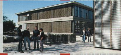
Pfosten/Riegel, aussen Baubronce, innen Aluminium, RMG 1.0, mit integriertem Glassteg zur Aufnahme der äusseren Storenführungs-Profile, Raff-Lamellenstoren mit ungebordelten Lamellen
