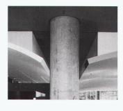
Bank. Zwei unterschiedlich gekrümmte Schalen in Gips-Leichtbautechnik geben dem nüchternen rechteckigen Grundriss Spannung und verleihen dem Raum neue Dimensionen. Die Schalen sind getrennt durch die im inneren Raumdrittel in Längsrichtung platzierten Stahlbetonsäulen und öffnen sich einmal zur Gartenseite, einmal zum Gebäude hin.
