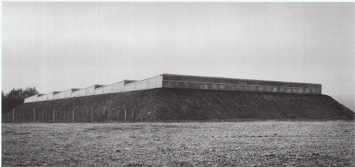
Das Weinlagerhaus ist im Grunde genommen ein Keller auf Erdgeschossniveau, indem das Gelände dreiseitig angeschüttet wurde, um die klimatischen Bedingungen des Flaschenlagers auf einfache Weise zu kontrollieren. In diese Aufschüttung ist eine Betonkonstruktion eingesenkt, überdacht von einem Stahlfachwerk mit Shed-Oberlichtern. Der Bau bezieht seine volumetrische Kraft durch die Verschmelzung von Gelände und Baustuktur, die in ein gemeinsames stereometrisches Spiel eingebunden sind.
