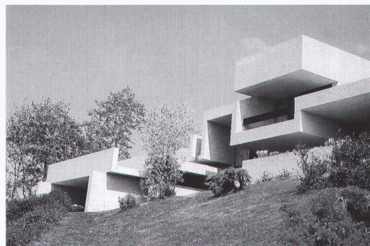
Haus Garrigue, Bayonne, 1970 Architekten: Yves Salier, Adrien Courtois, Pierre Lajus
