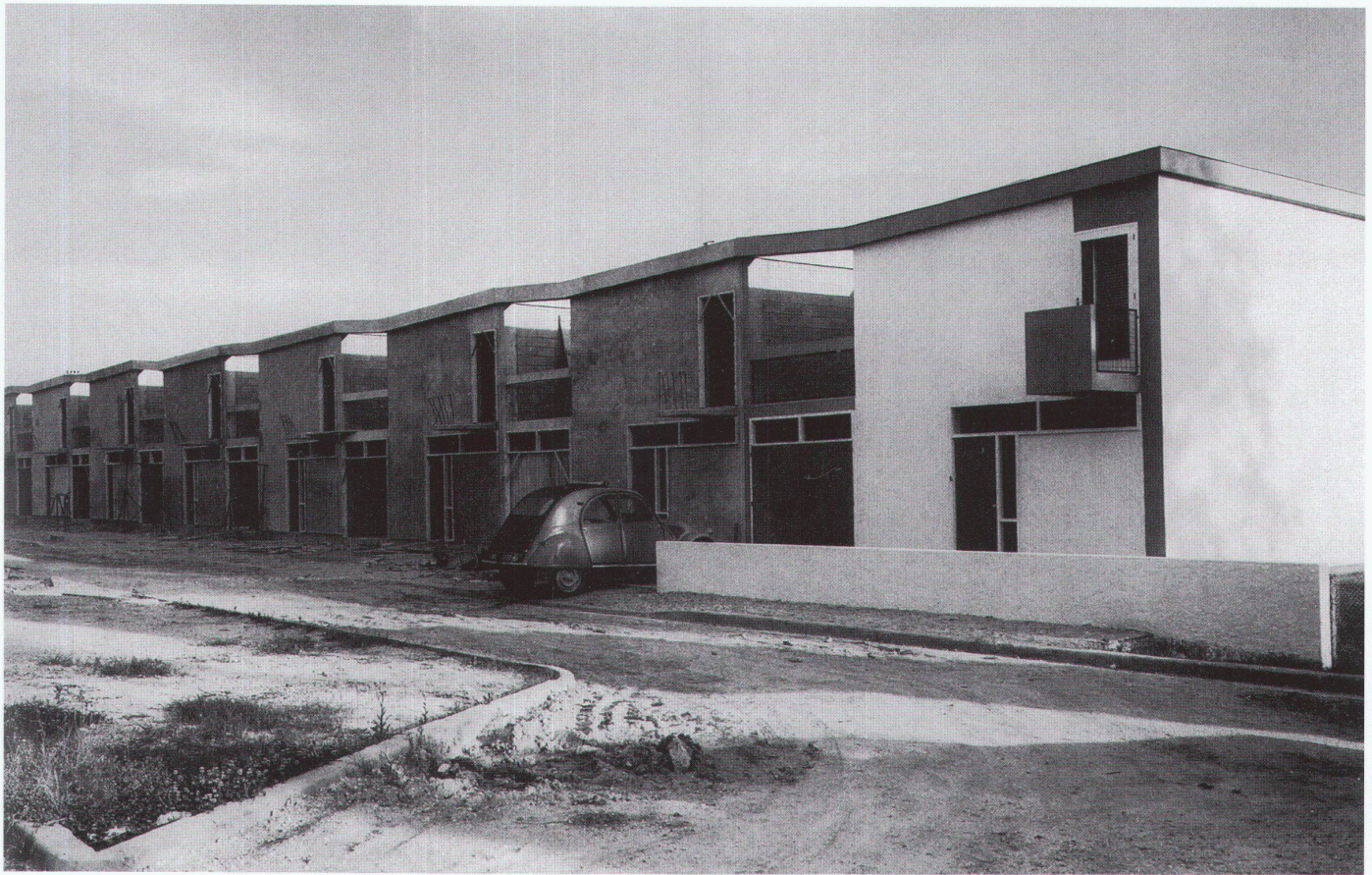
Siedlung Béchade, Le Haillan, 1957/58 Architekten: Yves Salier, Adrien Courtois
