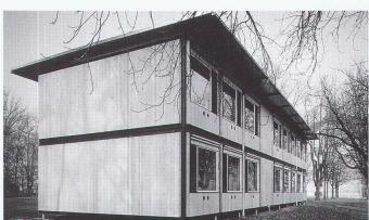
Der Pavillon wird in Leichtbauweise erstellt. Die einzelnen Elemente sind klar ablesbar. Die Haupträume sind zweiseitig belichtet, damit jeweils auf Besonnung und Zugangssituation reagiert werden kann.
