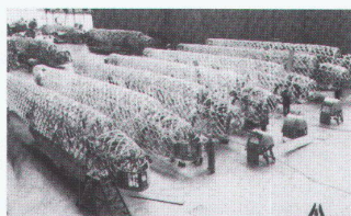
Abb. 11: Geodätische Strukturen der Wellington-Bomber, Vickers Factory, GB. Aus: Martin Bouwman: Wellington – The Geodesic Giant, 1989 (Seminar)
