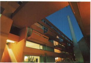
Balkone mit seitlicher Verglasung und Brüstungsschlitzen auf Kinderaugenhöhe ▷ Balcons avec vitrage latéral et fentes en allège à hauteur d'œil des enfants ▷ Balconies with lateral glazing and parapet viewing slits at the eye-level of children
