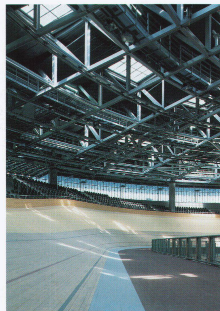
Fachwerkdecke ▷ Plafond en treillis ▷ Ceiling trusswork
