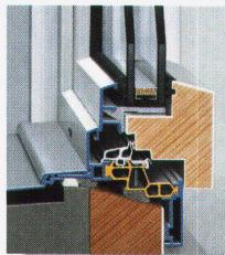
geben sich nie dagewesene Wärmedämmwerte. Die neue Rahmenkonstruktion mit optimierter Statik ermöglicht grössere Fensterflächen für mehr Tageslicht und verlängert die Lebensdauer. Die Erfindung des 4B Wabenisolators bringt mehr Wohnkomfort bei messbar geringeren Energiekosten. Hinzu kommt selbstverständlich das 4B Prinzip der sauberen Renovation: Ohne Baustelle und ohne Folgekosten. Montage in 1 Stunde. Qualität für Jahrzehnte.
