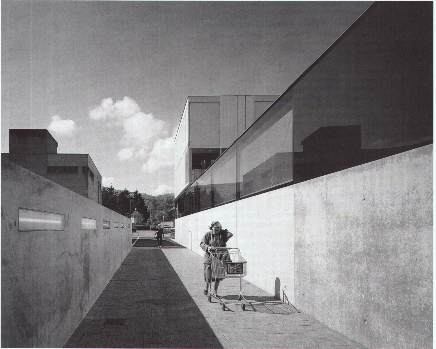
Sockelbereich (Supermarkt und Dachgarten)
