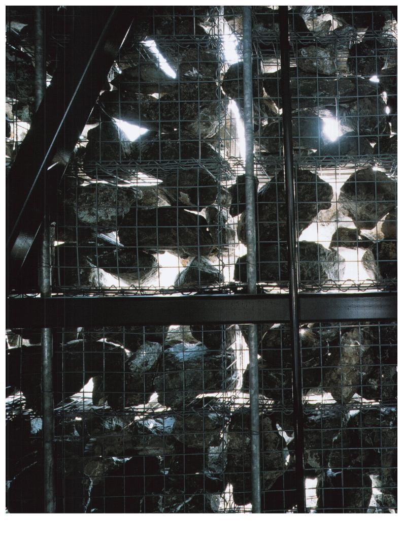
aus einem nahegelegenen Canyon stammenden Basaltsteine sind in Drahtkörben geschichtet, die durch eine innenliegende Stahlkonstruktion gehalten werden (solche Drahtkörbe dienen sonst dazu, bei Sprengungen Steinschläge abzufangen).
